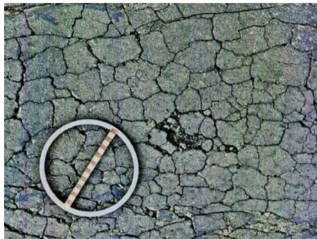
Figura 5 – Trinca Interligada do tipo “couro de jacaré”. Fonte DNIT 005/2003.
