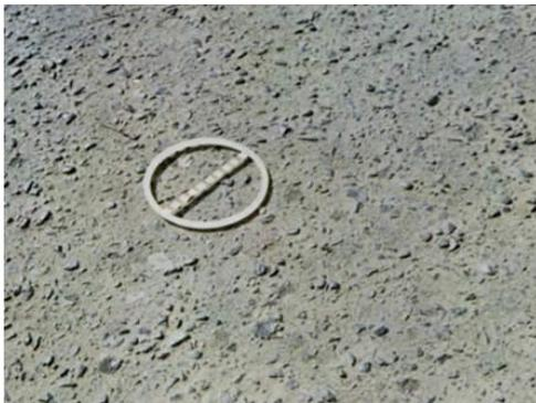
Figura 6 - Desgaste da superfície asfáltica. “Fonte DNIT 005/2003”.
