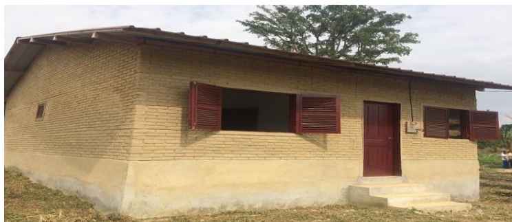
Figura 7: Protótipo de casa popular construída com tijolo solo-cimento
