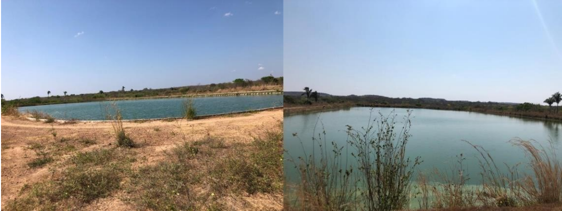
Figura 2 - Lagoa 1 e 2 da ETE
