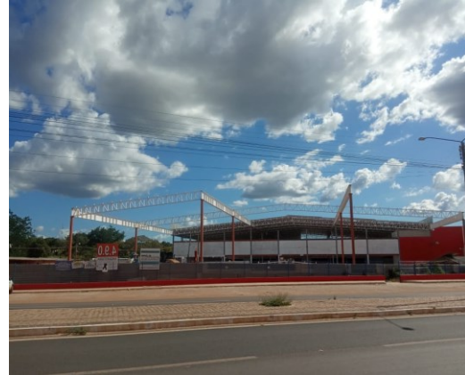
Figura 2 – Frente do Canteiro de obras.
