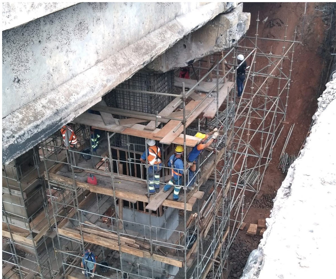
Figura 13 – Execução da Armadura de Reforço Fonte: Artigo publicado no site do grupo A HORA
