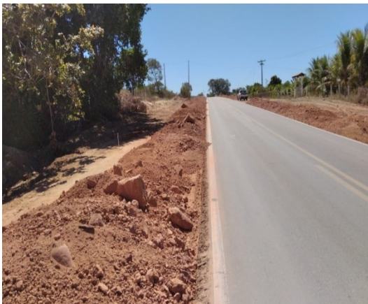
Execução de base
