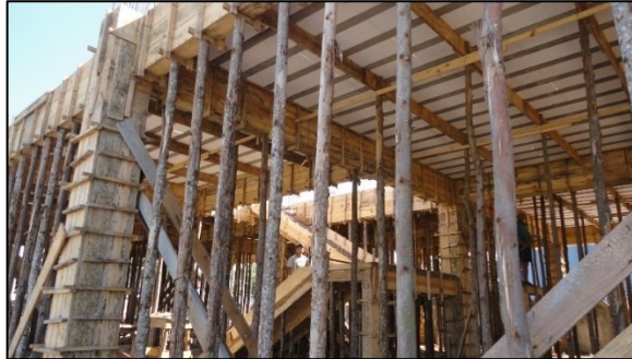
Figura 5- Escoramentos em laje pré-moldada
